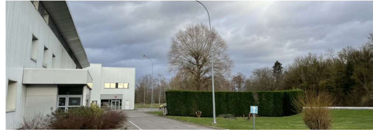
VUE SUR L'ESPACE ENTRE LA FORÊT ET LA FAÇADE SUD DU BÂTIMENT R (CÉPHALOSPORINES)
