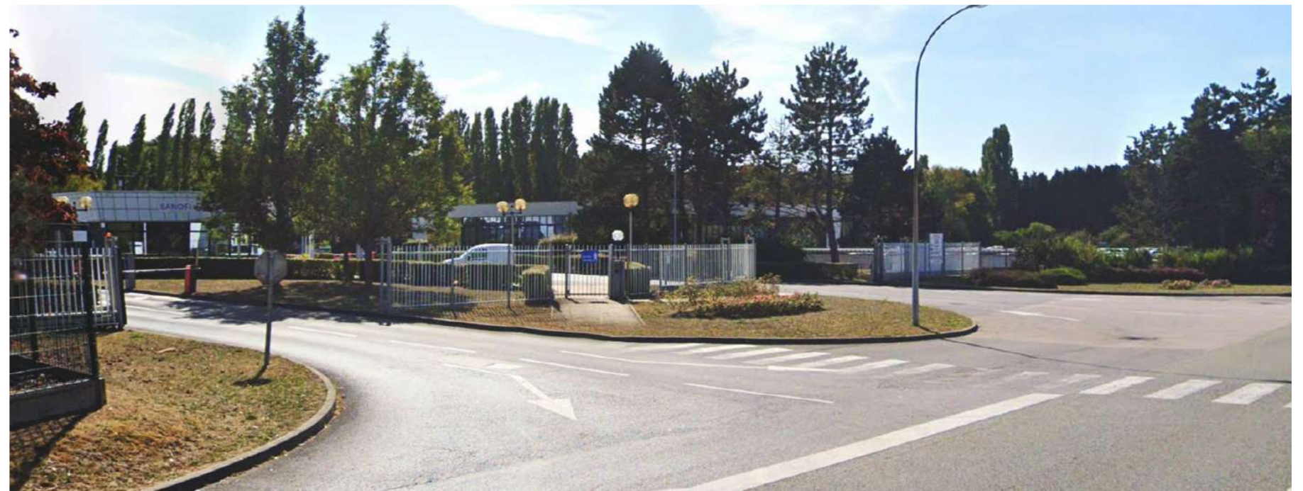
Insertion du mur de digue sur la route de Choisy au niveau de l'accès au Site - état existant
