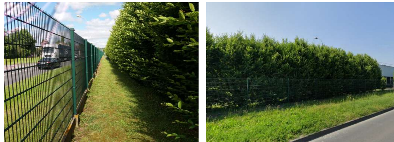
Vue de la clôture et de la haie existante qui sera conservée, depuis l'intérieur et l'extérieur du site.
