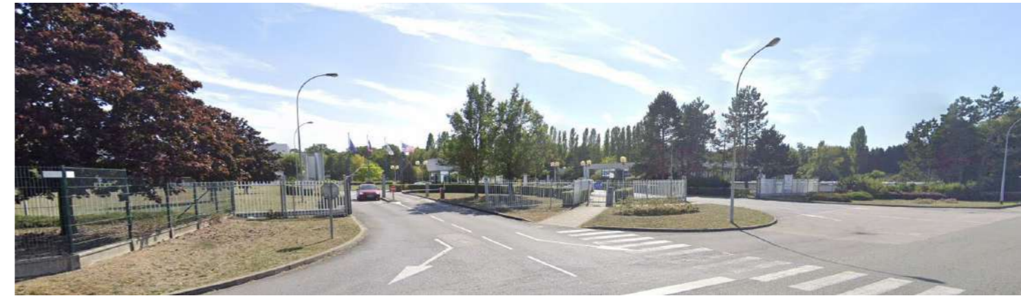
VUE SUR L'ENTRÉE ACTUELLE DU SITE DE SANOFI COMPIÈGNE - 56 ROUTE DE CHOISY
