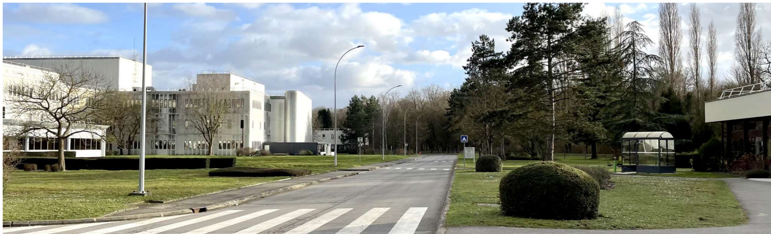
VUE DE LA VOIRIE DEVANT LE RESTAURANT D'ENTREPRISE
