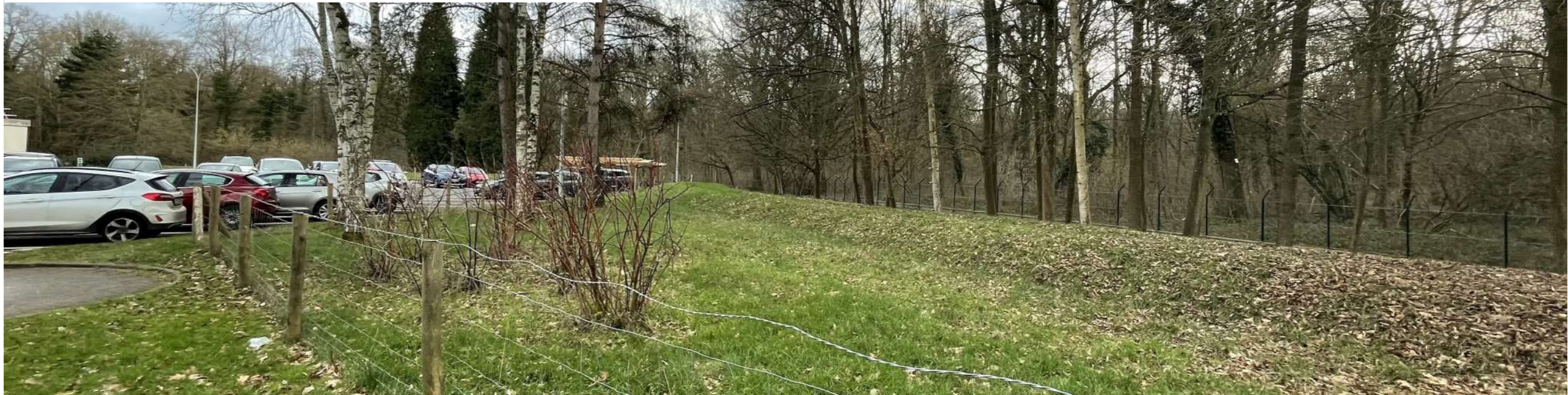
VUE DE LA DIGUE EXISTANTE ENTRE LE PARKING NORD ET LA LIMITE DU SITE
